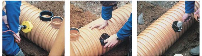
Присоединять дренажные трубы к дренажному колодцу удобнее всего по месту монтажа. Сначала торцевой фрезой соответствующего диаметра вырезается отверстие в гофротрубе колодца. В отверстие вставляется резиновое уплотнение, являющееся составной частью перехода «In Situ» для подключения к колодцу «по месту». На внутреннюю поверхность уплотнения наносится силиконовая смазка, после чего вставляется пластиковая муфта перехода «In Situ».
